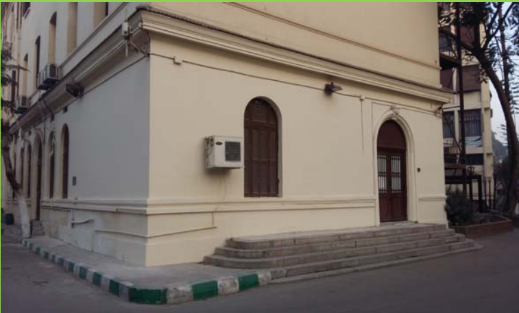
الحوائط خارج عيادة الكلية بعد الانتهاء من أعمال التكسير والمحارة والدهانات
