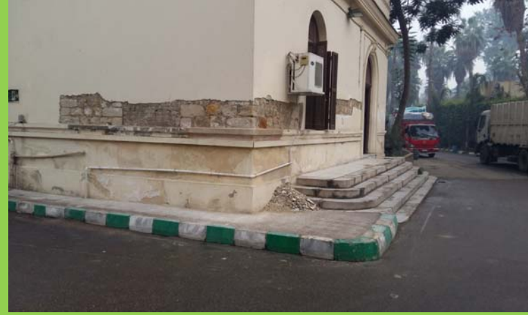
أعمال تكسير وإزالة الأجزاء المتهاكلة خارج عيادة الكلية
