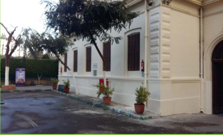
الحوائط الخارجية لمدرج ١١٠١ بعد الانتهاء من أعمال الترميم والدهانات
