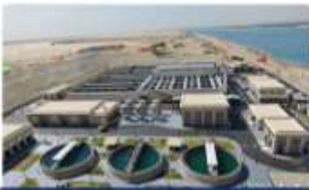
محطة معالجة مياه مصرف بحر البقر
